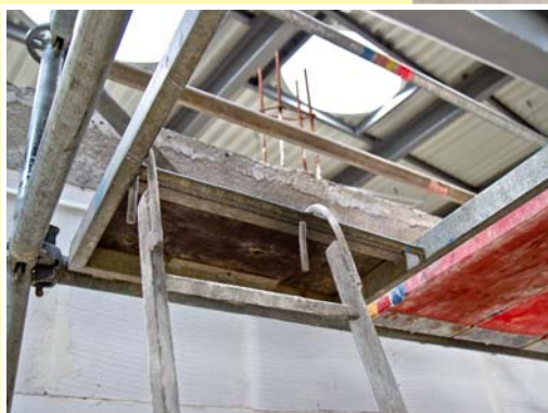
Umocowanie drabiny za pomocą haków za jej górnej części.
