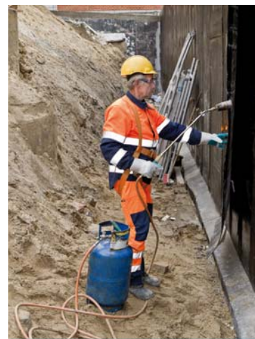
Працівник може працювати тільки у виїмці, яка захищена від обвалення ґрунту
